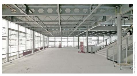
Bild 3 Schulhaus Auen 1, bestehende Tragstruktur System CROCS Schoolhouse Auen 1, existing support structure system CROCS
